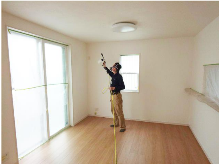
抗ウイルス抗菌コーティング「レコナガード エアフレッシュ」新築住宅への施工の様子
