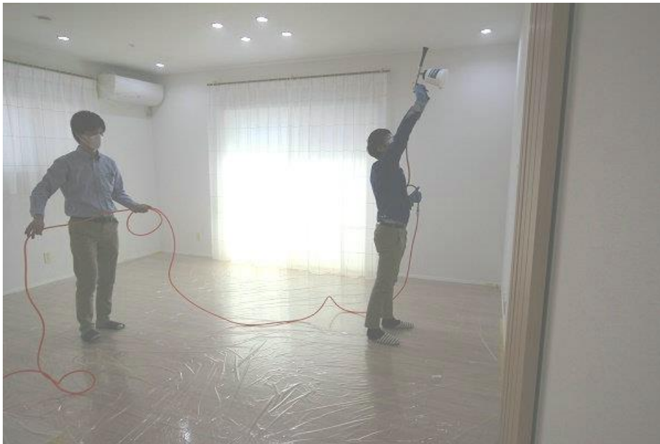
光触媒コーティング施工の様子
