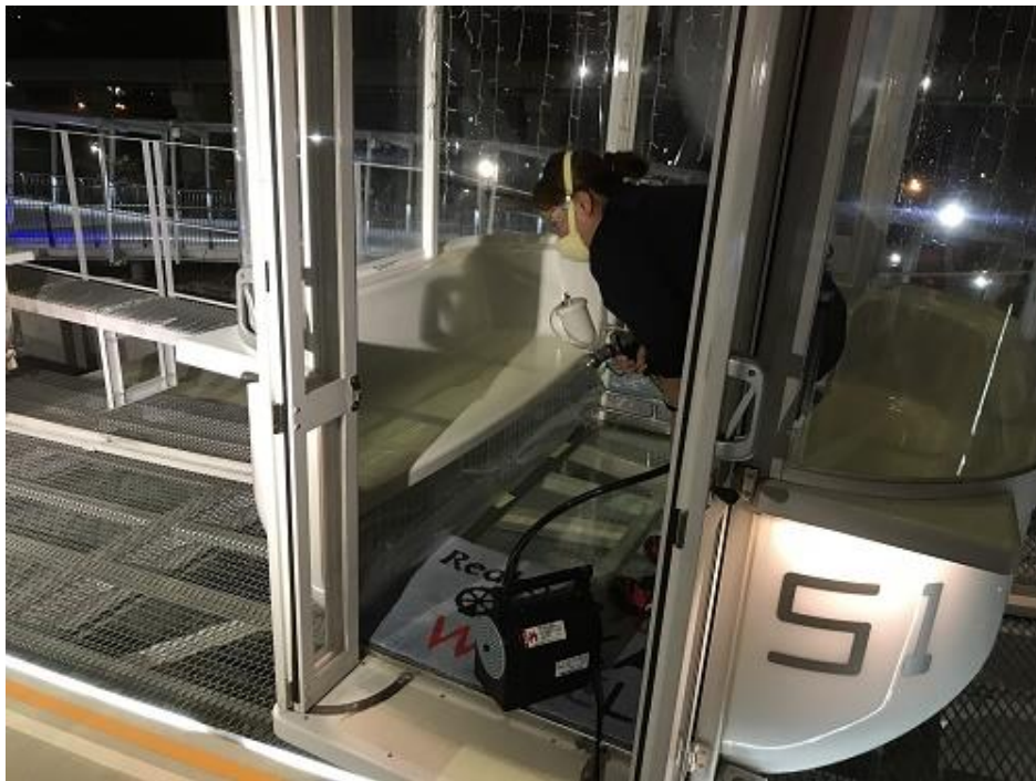
抗ウイルス抗菌コーティング(「レコナガード エアリフレッシュ」) 観覧車の施工の様子
